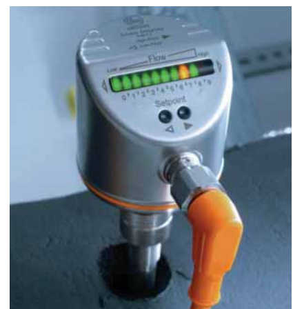
Блок оценочной электроники для монтажа на месте.
